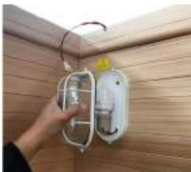
(14) Installare la copertura impermeabile delle luci della sauna, basta usare le viti, vedere la foto sopra, le viti sono 4x12mm
