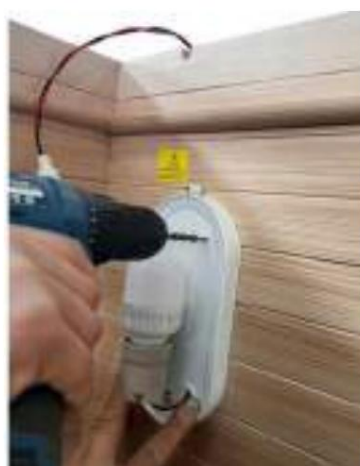
(13) Utilizzare viti per fissare il coperchio della luce della sauna, vedere sopra, utilizzare viti da 3,5x25 mm 2 pezzi
